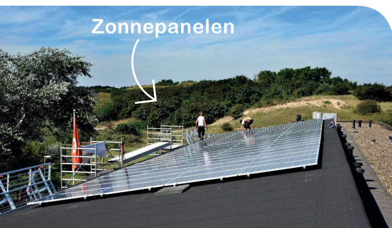
Plaatsing zonnepanelen op de Banjaert
