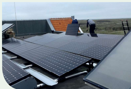
Plaatsing zonnepanelen op Zeehuis
